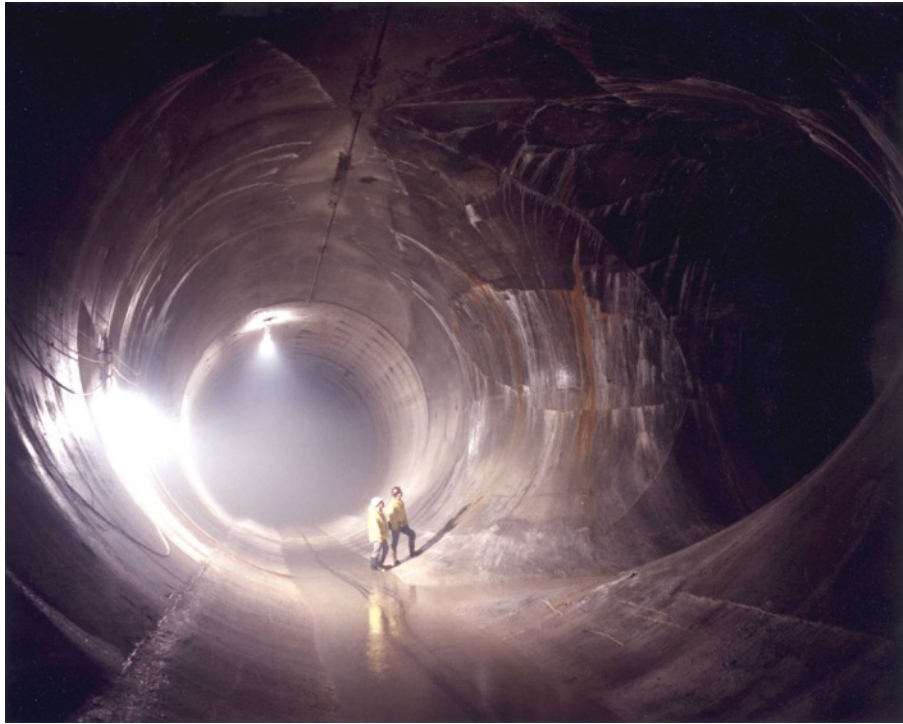
CSO Tunnel Milwaukee, WI
